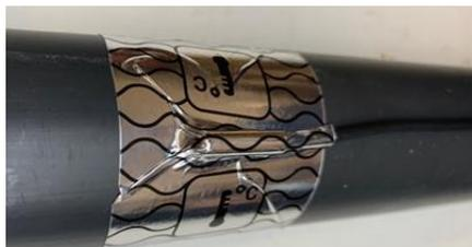
Figure 4 – Installation de la sonde de température
